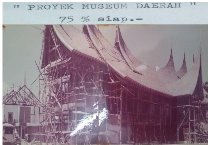
Gambar 03. Proses Pengerjaan Bangunan Fisik Museum (Sumber : Arsip Museum, 1976 )
