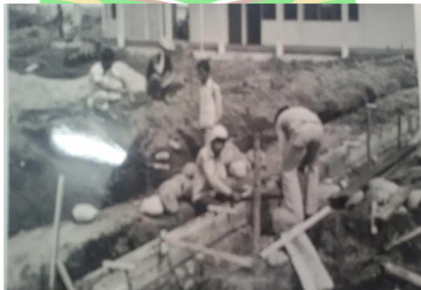
Gambar 02. Proses Pengerjaan Bangunan Fisik Museum (Sumber : Arsip Museum, 1974)
