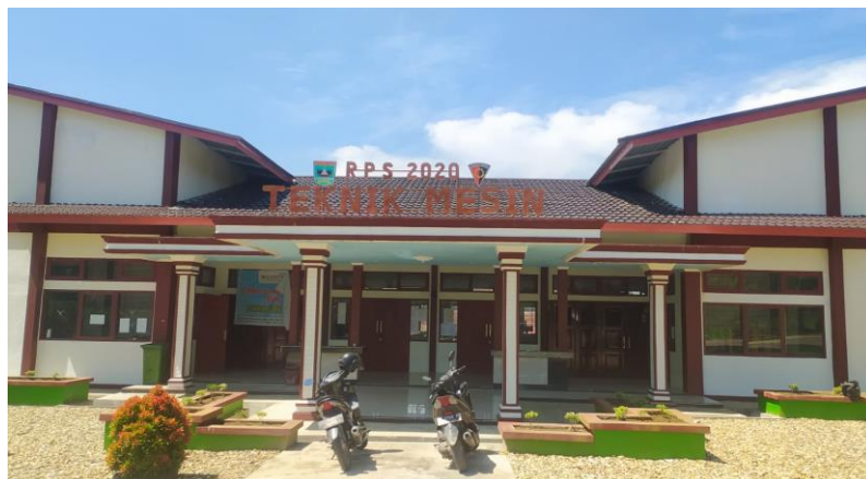
Gambar 5. Salah Satu Bangunan Baru di SMKN 2 Solok
