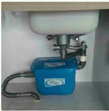
**Gambar 33. Pemasangan Grease Trap**
