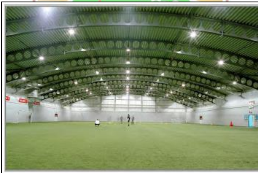
Gambar 1. 2 Penggunaan Balok Kastela pada Gedung Olah Raga
