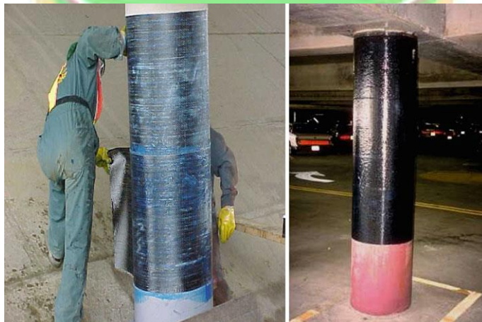
Gambar 1.5 Penggunaan lembaran CFRP di lapangan (Saatcioglu, 2013)
