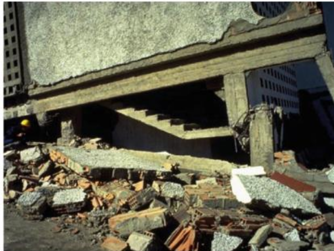
Gambar 1.1 Gaya lateral dari plat tangga pada kolom menyebabkan kegagalan geser selama gempa El Asnam 1980 di Algeria. (Saatcioglu, 2013)
