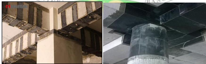
Gambar 1.2 Penggunaan Perkuatan Struktur Beton Bertulang di Lapangan (Mahajan, 2021)
