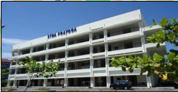
Gambar 1.1 Bangunan STBA PRAYOGA Padang
