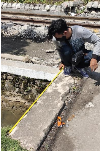
Pengukuran dimensi (lebar saluran primer 3)
