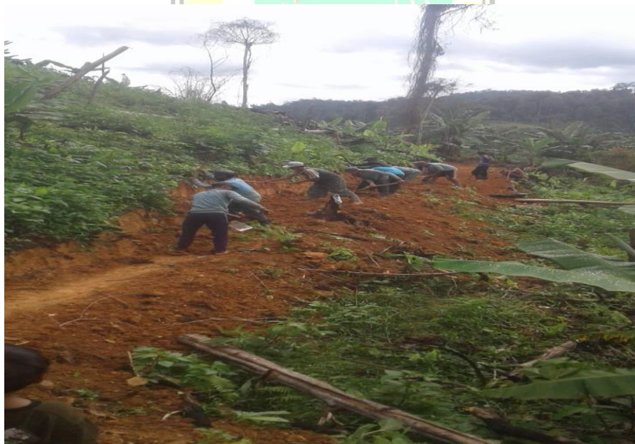
Gambar 4. Gotong Royong dalam Pembangunan Jalan
