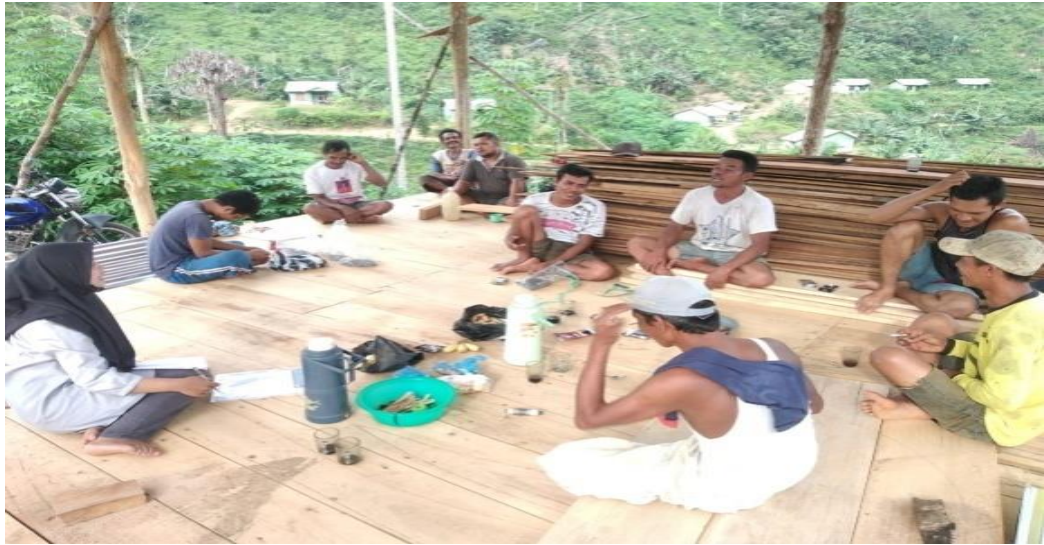
Pembangunan Mushalah Blok B secara gotong-royong
