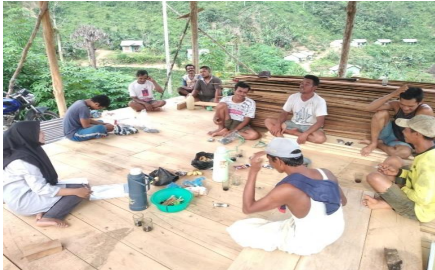
Gambar 5. Gotong-royong dalam pembangunan mushola
