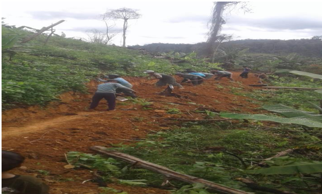
Kegiatan gotong-royong membangun jalan antar Blok
