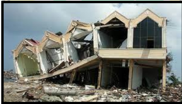
Gambar 1. 1 Kerusakan Gedung Akibat Gempa
