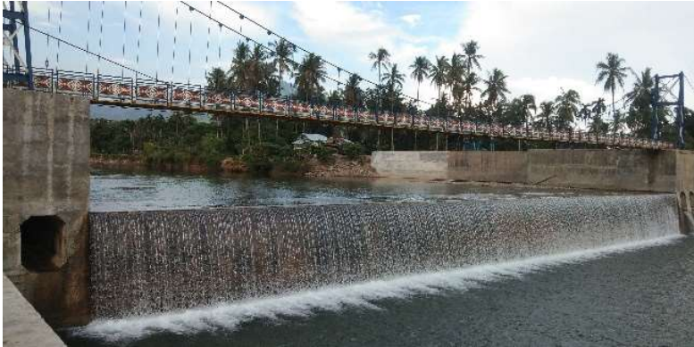
Gambar 1. 4 Check dam Koto Tuo (Sumber: Dokumentasi pribadi)
